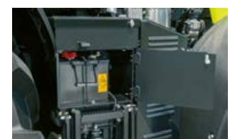
Rechts im Aufstieg befindet sich gut zugänglich die Batterie.
